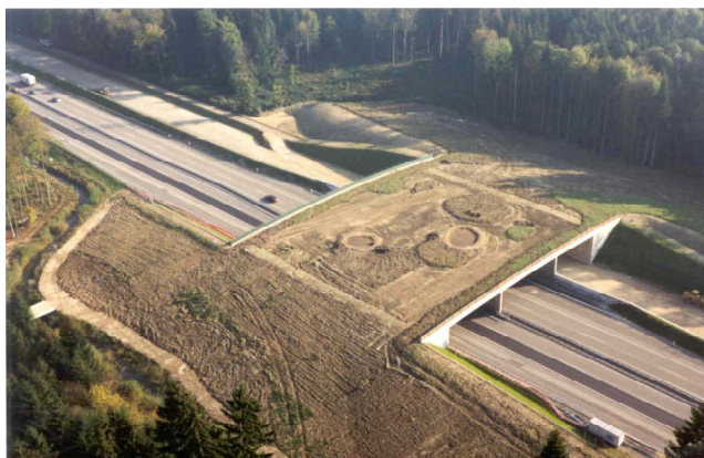
Fig. 3. Ecoduct, în construcție, cu lățime 50 m peste autostrada existentă și linia C.F., Neu-Ischlag, Cantonul Bern, Elvetia.
